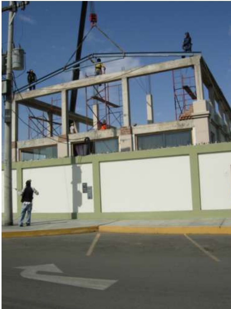
La posa della prima capriata ...
