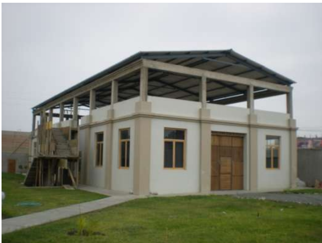
Ormai la posa della copertura è completata ed anche la scala esterna è quasi pronta ...
